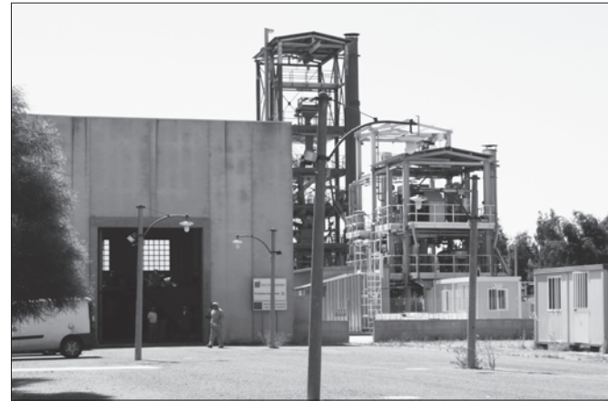
Gli impianti della Sotacarbo.
