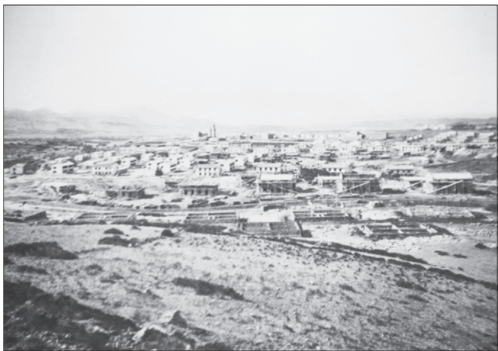
Le prime case in costruzione.
