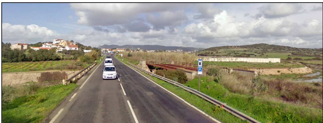
Figura 6 - Ponte sul Rio Milano
