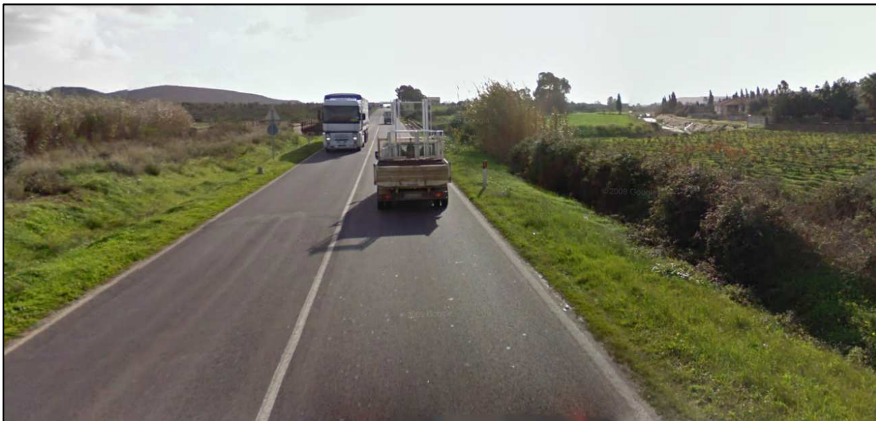
Figura 7 - Ponte sul Rio Milano
