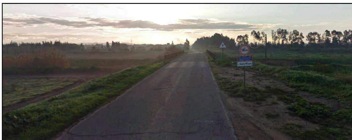
Figura 15 - Ponte sul rio Santu Milanu
