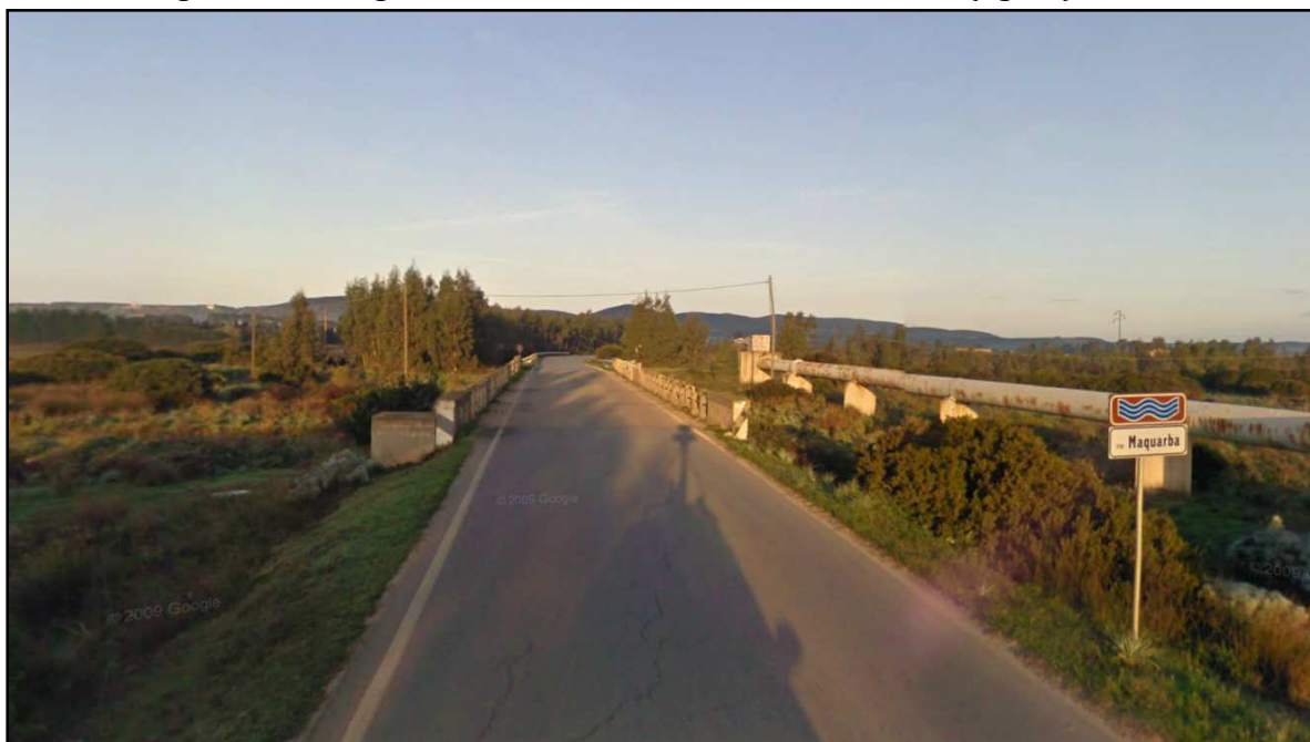
Figura 12 - Attraversamento del Rio Maquarba
